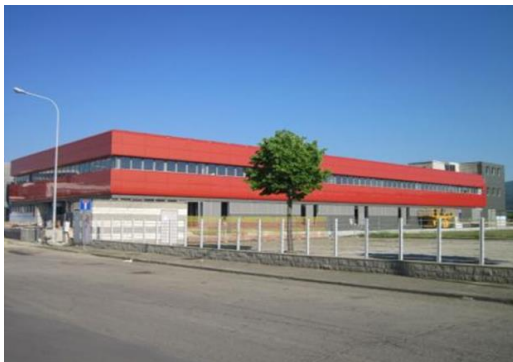
Figura 5: Immagine esterna del Datacenter
